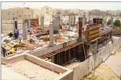
ISC-Doha Construction Site
